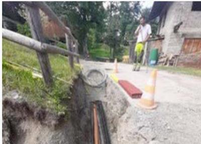
*Grabungsarbeiten für unser Glasfasernetz, Wasserleitung und Tinetz*
